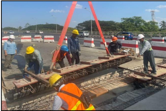
Expansion Joint ပြုပြင်ခြင်းလုပ်ငန်းဆောင်ရွက်နေပုံ
