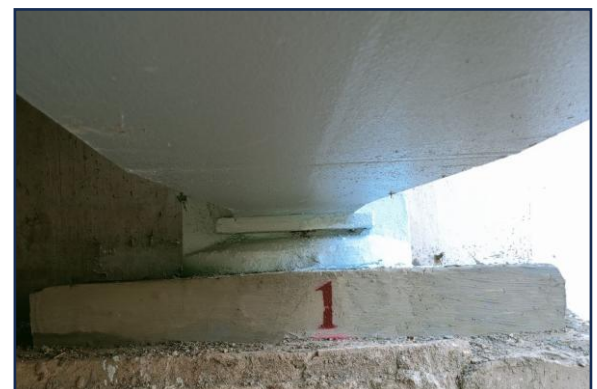
Bearing ခုံ ပြုပြင်ခြင်းလုပ်ငန်း ဆောင်ရွက်ပြီးစီးပုံ
