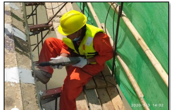
Rebar Stapler Pin Hook တပ်ဆင်နိုင်ရန် အပေါက်များ ဖောက်နေပုံ
