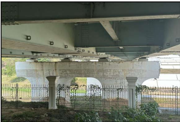
Steel Box Girder များ ရေစုန်ဘက်သို့ ရွှေ့သွားပုံ
