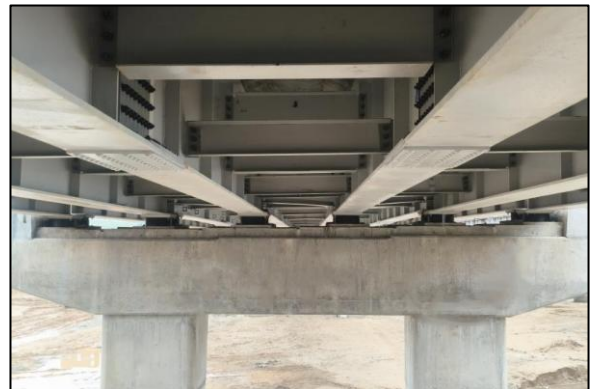
ဆွာချောင်းတံတား Lead Rubber Bearing များ တပ်ဆင်ခြင်း ပြုပြင်ပုံ မှတ်တမ်းများ
