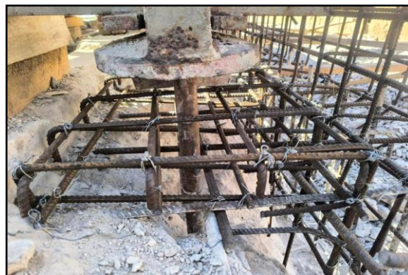
Bearing ခုံ ပြုပြင်ခြင်းလုပ်ငန်းဆောင်ရွက်နေပုံ
