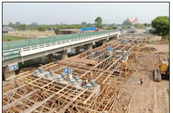
ယုနေတံတား High Dumping Rubber Bearing များ တပ်ဆင်ခြင်း ပြုပြင်ပုံ မှတ်တမ်းများ
