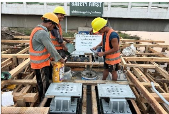
ယုနေတံတား High Dumping Rubber Bearing များ တပ်ဆင်ခြင်း ပြုပြင်ပုံ မှတ်တမ်းများ
