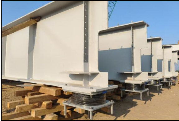
ဆွာချောင်းတံတား Lead Rubber Bearing များ တပ်ဆင်ခြင်း ပြုပြင်ပုံ မှတ်တမ်းများ
