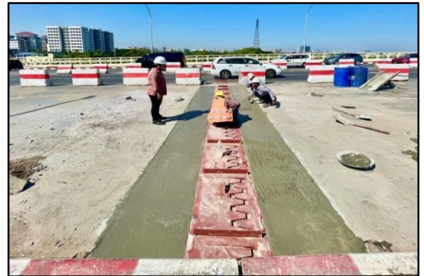
Expansion Joint ပြုပြင်ခြင်းလုပ်ငန်း ဆောင်ရွက်ပြီးစီးမှု
