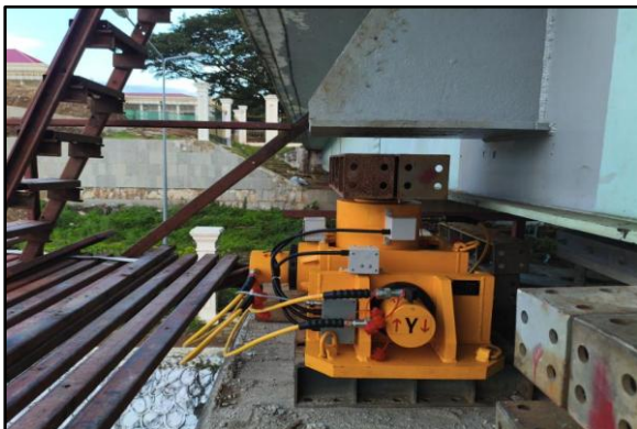
3D Jack ဖြင့် Steel Box Girder များအထိုင်ချခြင်းလုပ်ငန်း ဆောင်ရွက်ပြီးစီးပုံ
