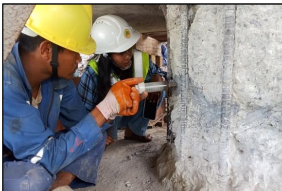
Injection Method ဖြင့် ပြုပြင်ခြင်းလုပ်ငန်း ဆောင်ရွက်နေပုံ
