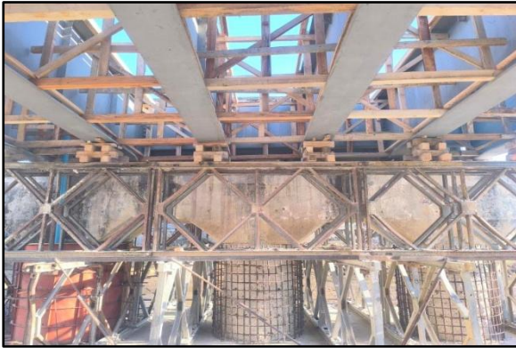
Pier တိုင် Jacketing လုပ်ငန်းဆောင်ရွက်နေပုံ
