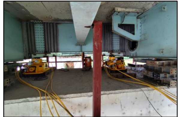
3D Jack ဖြင့် Steel Box Girder များအထိုင်ချခြင်းလုပ်ငန်း ဆောင်ရွက်ပြီးစီးပုံ
