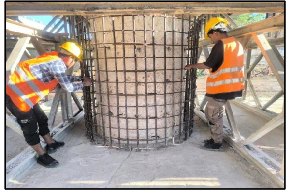
Pier တိုင် Jacketing လုပ်ငန်းဆောင်ရွက်နေပုံ
