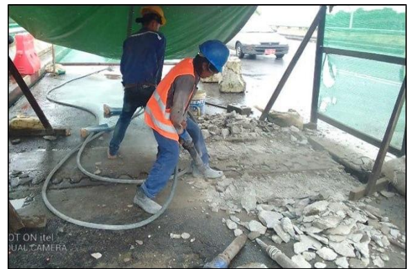
Expansion Joint ပြုပြင်ခြင်းလုပ်ငန်းဆောင်ရွက်နေပုံ
