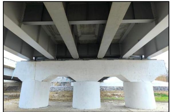
Pier တိုင် Jacketing လုပ်ငန်းဆောင်ရွက်ပြီးစီးပုံ
